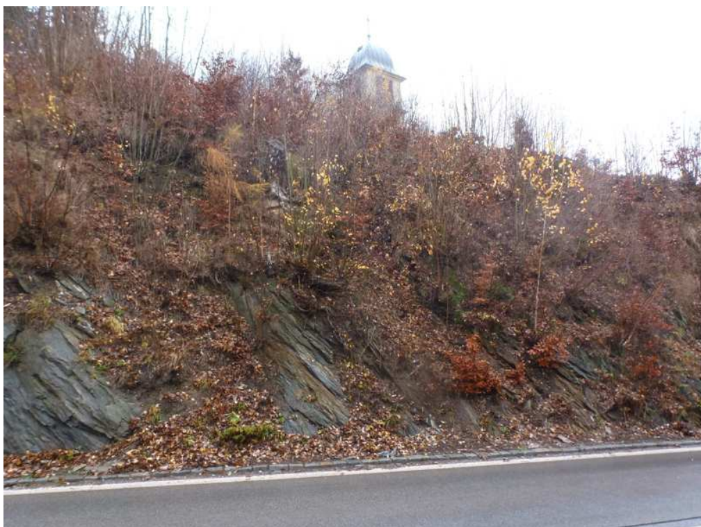
Střední část skalního svahu, vzrostlý nálet a nefunkční akumulací prostor.
