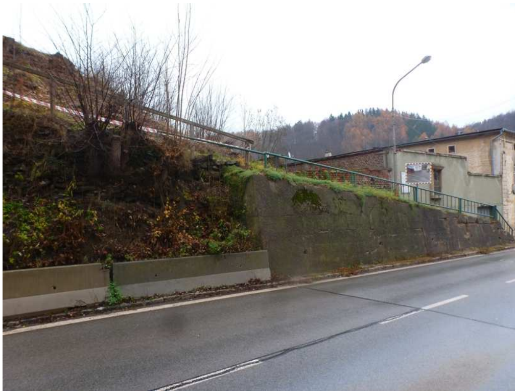
Navazující bet. opěrná zídka bude nahrazena gabionovou kotvenou k-cí.
