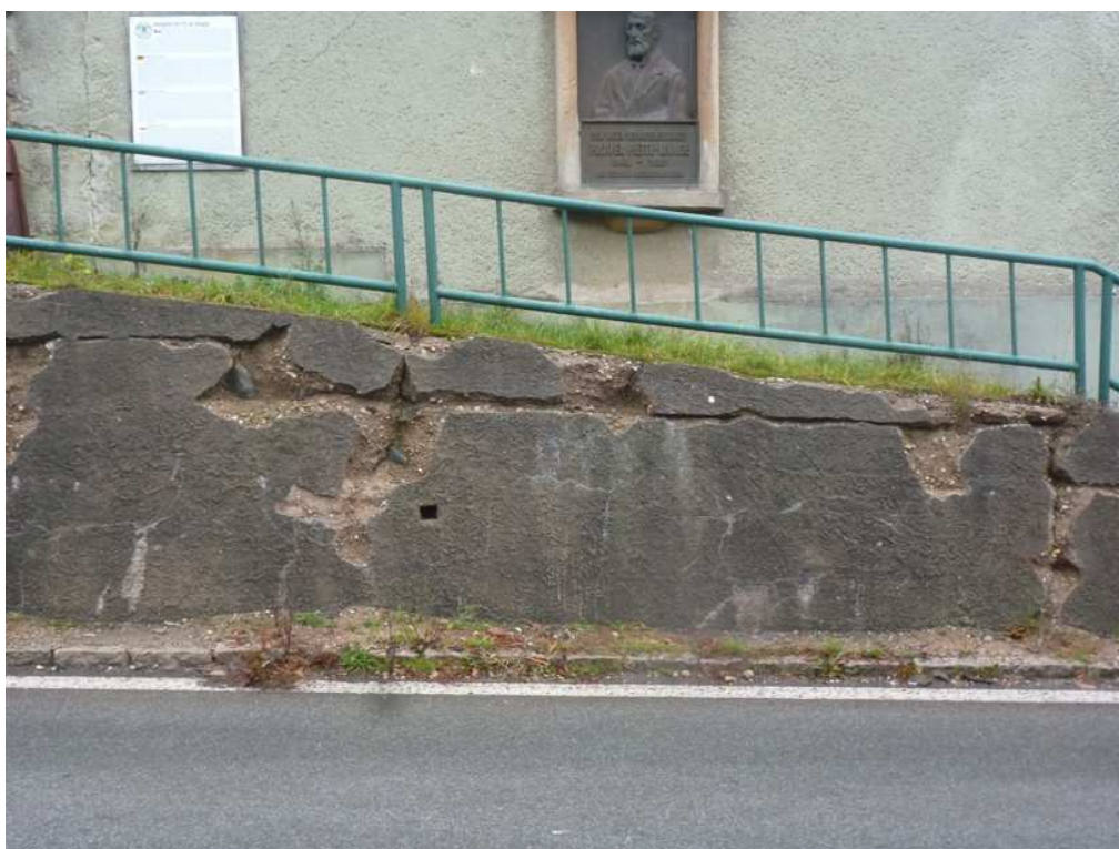
Detailní pohled na stav zídky, která je již v pokročilém stádiu rozpadu.
